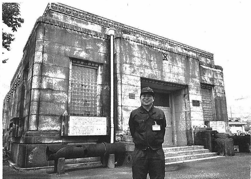
浄水場にある薬品注入機室
